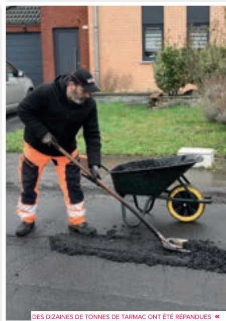
DES DIZAINES DE TONNES DE TARMAC ONT ÉTÉ RÉPANDUES ◀
