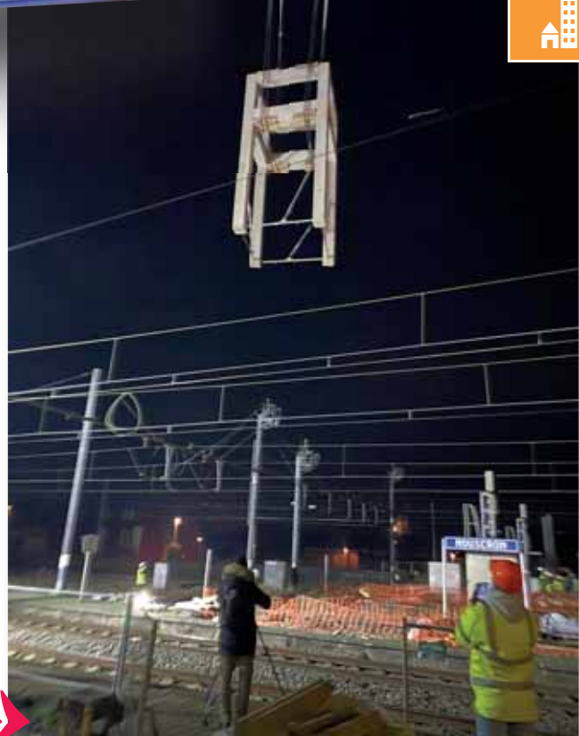
LES PILES DE LA PASSERELLE ONT ÉTÉ INSTALLÉES DURANT LES NUITS DU 28 JANVIER ET DU 3 FÉVRIER «
